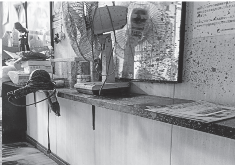
仙北市西木町上松木内 床上浸水した美容室
